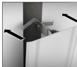
3. Cubrejuntas listo para colocar
