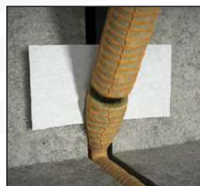
Empalme de 2 longitudes (sistema patentado).
