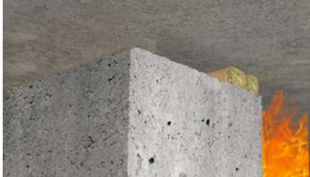
Dos cordones del lado expuesto
