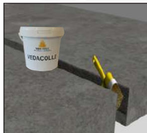
Encolar las dos caras de la junta con la cola VEDACOLLE®.
