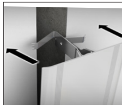
3. Cubrejuntas listo para colocar
