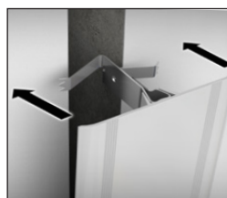
3. Cubrejuntas listo para colocar
