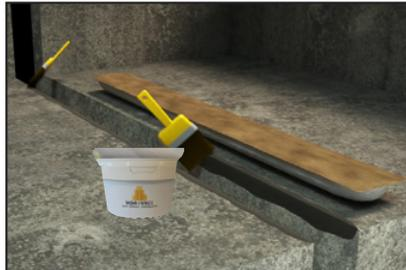
Encoller les deux côtés du joint sur 100 mm de hauteur ainsi qu'une bande de 5 cm sur la partie supérieure du béton avec de la VEDACOLLE<sup>®</sup>.
