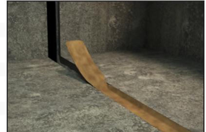
Insérer la nappe VEDAFEU M<sup>®</sup> dans le joint.
