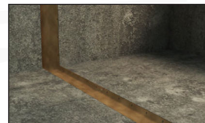
La capa VEDAFEU M ® está instalada.
