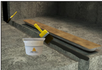
Encole los dos lados de la junta sobre 100 mm de altura así como un ancho de 5 cm en la parte superior del hormigón, con la cola VEDACOLLE ®** .
