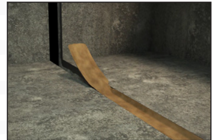
Introduzca la capa VEDAFEU M ® dentro de la junta.
