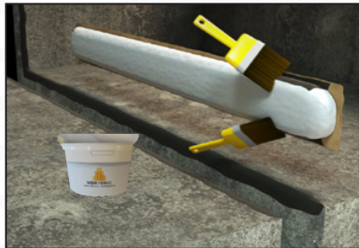
Encole la parte de abajo de las aletas así como la parte vertical de la capa, sobre una anchura de 6 cm.
