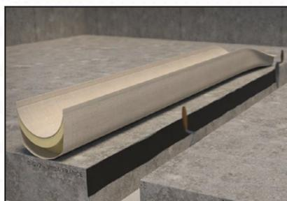
Encole los dos lados de la junta en una profundidad de unos 90 mm utilizando la cola VEDACOLLE®.
