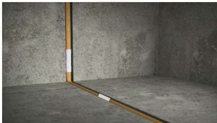
Aplicación en suelo y pared con empalmes.
