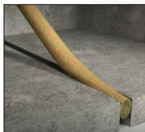
Antes de que la cola se seque, introducir el cordón VEDAFEU C®.
