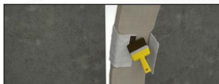
Entourer le raccord VEDAFEU autour du raccordement et le fermer avec une bande de colle.
