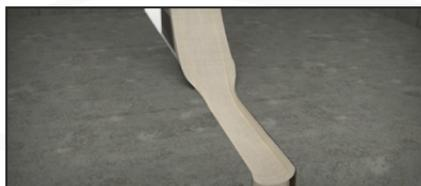
Insérer la nappe VEDAFEU N20<sup>®</sup> dans le joint avant que la colle ne sèche.
