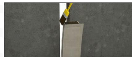
Pour raccorder deux longueurs de nappe, appliquer de la colle au bout des nappes et les positionner bout à bout en force.
