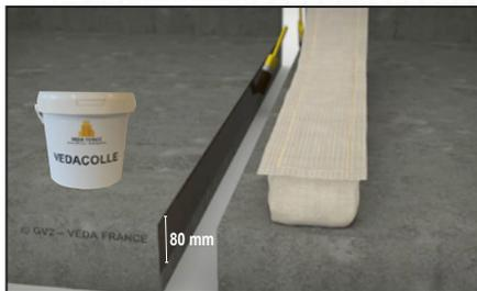
Encoller les deux côtés à l'intérieur du joint sur une hauteur de 80 mm environ à raison de 1kg/ml sur la partie supérieure du béton avec de la VEDACOLLE<sup>®\*\*</sup>.
