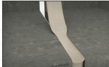
Insérer la nappe VEDAFEU N20<sup>®</sup> dans le joint avant que la colle ne sèche.
