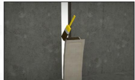
Pour raccorder deux longueurs de nappe, appliquer de la colle au bout des nappes et les positionner bout à bout en force.
