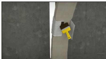
Entourer le raccord VEDAFEU autour du raccordement et le fermer avec une bande de colle.
