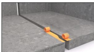
Coloque una cinta adhesiva de limpieza sobre los bordes de la junta. Pegue el interior de la junta con la cola VEDACOLLE<sup>®</sup>.
