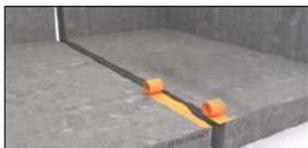
Mettre en place un adhésif de propreté sur les bords du joint. Encoller l'intérieur du joint avec la colle VEDACOLLE<sup>®</sup>.
