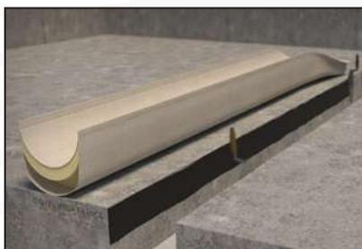
Encoller les deux côtés du joint sur une profondeur de 90 mm environ à l'aide de la VEDACOLLE<sup>®</sup>.
