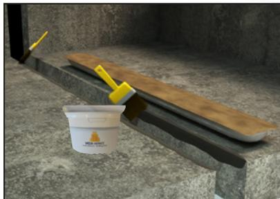
Encole los dos lados de la junta sobre 100 mm de altura así como un ancho de 5 cm en la parte superior del hormigón, con la cola VEDACOLLE<sup>®</sup>.
