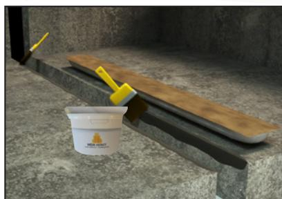
Encoller les deux côtés du joint sur 100 mm de hauteur ainsi qu'une bande de 5 cm sur la partie supérieure du béton avec de la VEDACOLLE<sup>®</sup>.
