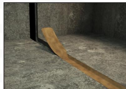
Insérer la nappe VEDAFEU M<sup>®</sup> dans le joint.
