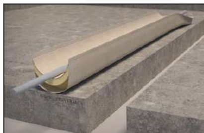
Préformer la nappe en U en la pliant dans sa partie centrale.
