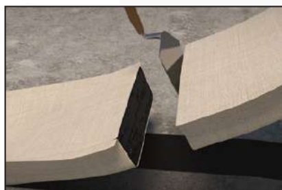
Pour raccorder deux longueurs de nappe, appliquer de la colle sur les extrémités des deux nappes. (Pour les joints > 100 mm la méthode de raccord est différente).
