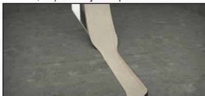
Insérer la nappe VEDAFEU N20<sup>®</sup> dans le joint avant que la colle ne sèche.
