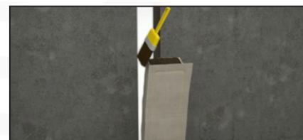
Pour raccorder deux longueurs de nappe, appliquer de la colle au bout des nappes et les positionner bout à bout en force.
