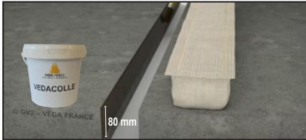
Aplique la cola VEDACOLLE<sup>®</sup> con una brocha en ambos lados del interior de la junta sobre una altura estimada de 80 mm a razón de 1 kg/ml de cola VEDACOLLE<sup>®</sup>\*\*.
