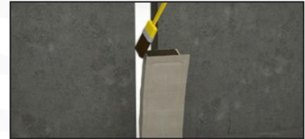
Para unir dos módulos de capa, aplique la cola en los extremos de ambos módulos y colóquelos, firmemente, uno tras otro.
