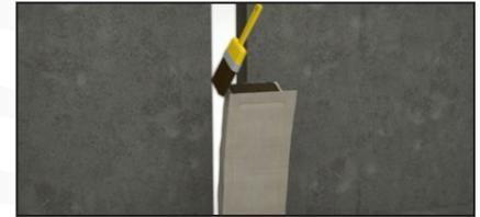
Pour raccorder deux longueurs de nappe, appliquer de la colle au bout des nappes et les positionner bout à bout en force.
